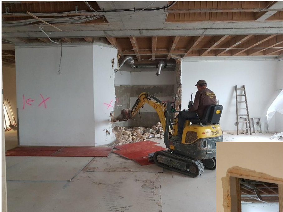
Die ersten Abbrucharbeiten
